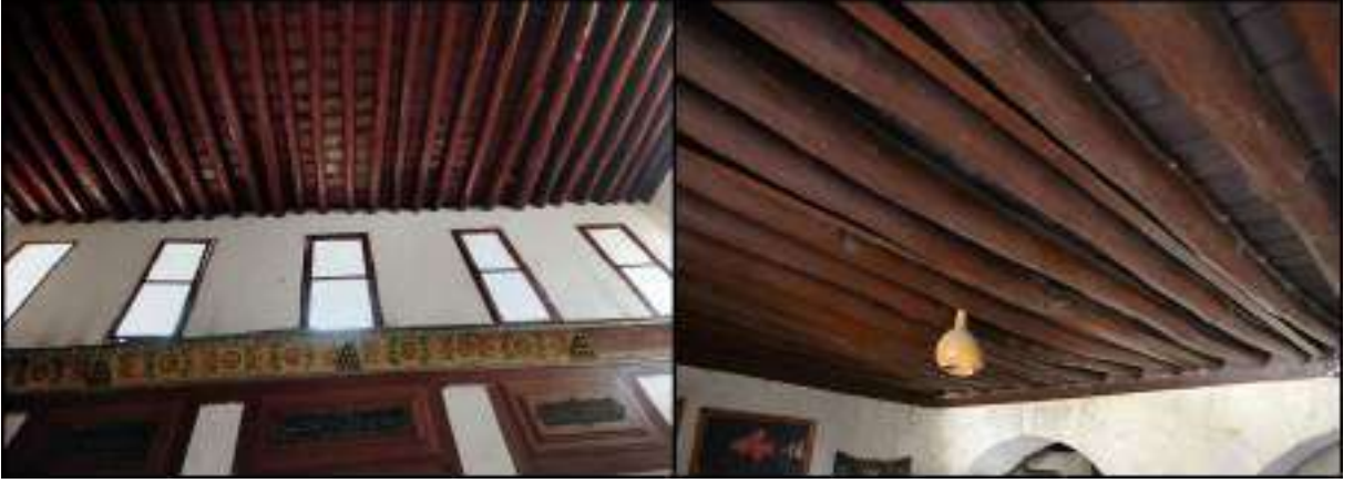
Şekil 14. Solda; Halep konutundan, 868 sağda; Gaziantep konutundan ahşap kirişli tavan örneği
