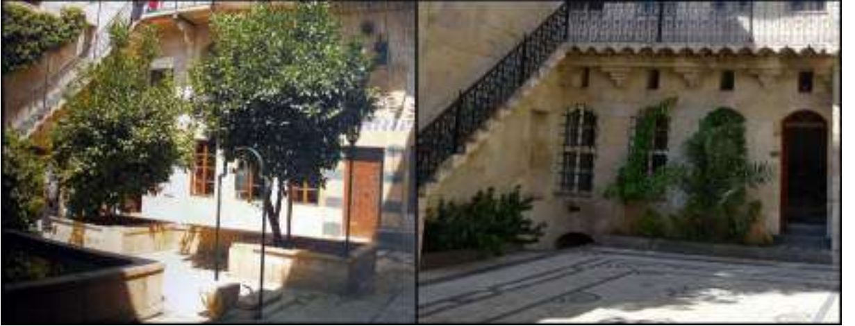
Şekil 12. Solda; Halep’ten, 865 sağda; Gaziantep’ten benzer avlu cephesi örnekleri
